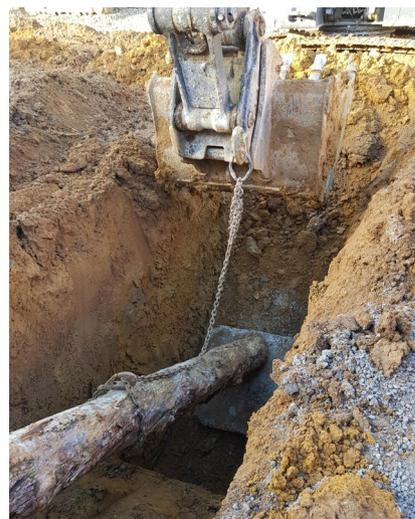
Figure 4-4 : Illustration du serrage d'un buton au niveau de la semelle
