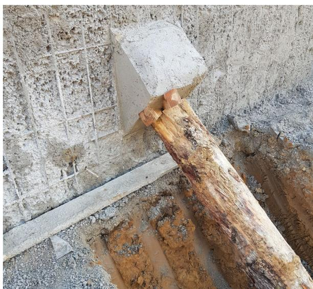
Figure 4-5 : Buton serré par des coins au niveau du corbeau
